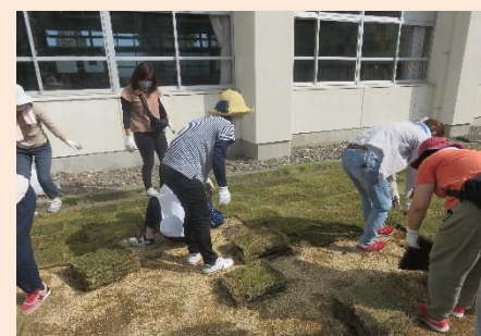
中庭改修作業
