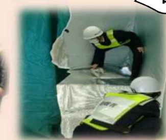
【屋内テント設営】
