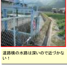
26 道路横の水路は深いので近づかない！
